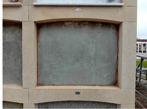
Detall revestiment de pedra i placa identificativa
