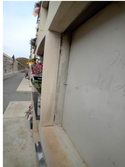
Detall interior, revestiment i tapa del nínxol
