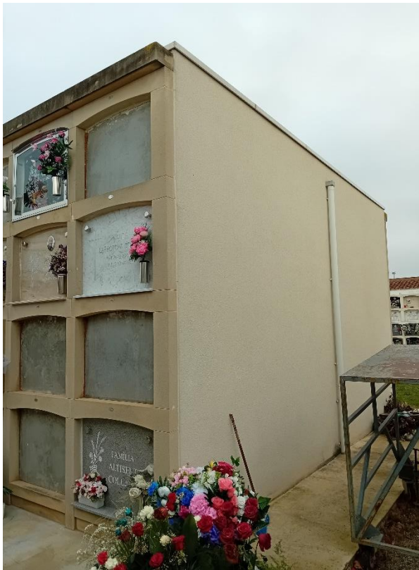
Cantonada del bloc amb baixant de coberta
