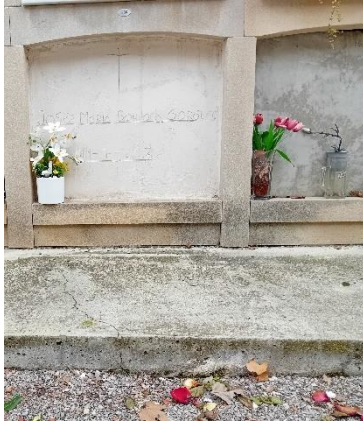
Detall part inferior de la columna, sòcol i vorera
