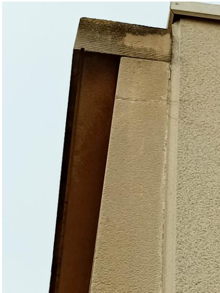
Detall monocapa, pedra, coronament i xapa coronament coberta
