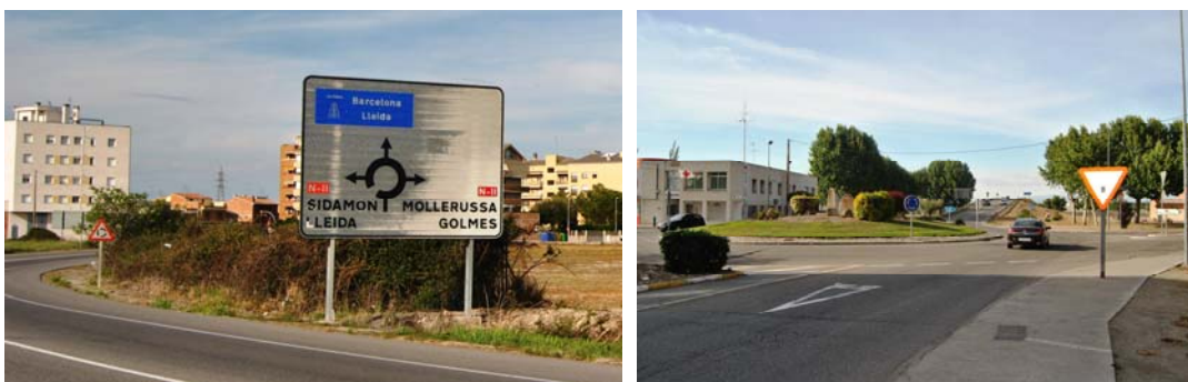
Fotos 4 i 5. Rotonda situada al Nord de l'àmbit del PMU, a l'encreuament entre la Ronda de Ponent i l'avinguda Jaume I (N-II), amb connexió directa a l'A-2 mitjançant l'E-23.
