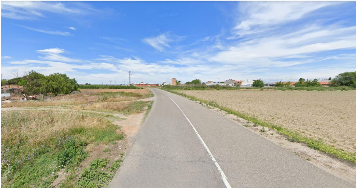
Imatge 27: Vista del sector SUBD-09 "NEGRALS NORD", en sentit SO-NE. Font: PAMPOLS ARQUITECTE
