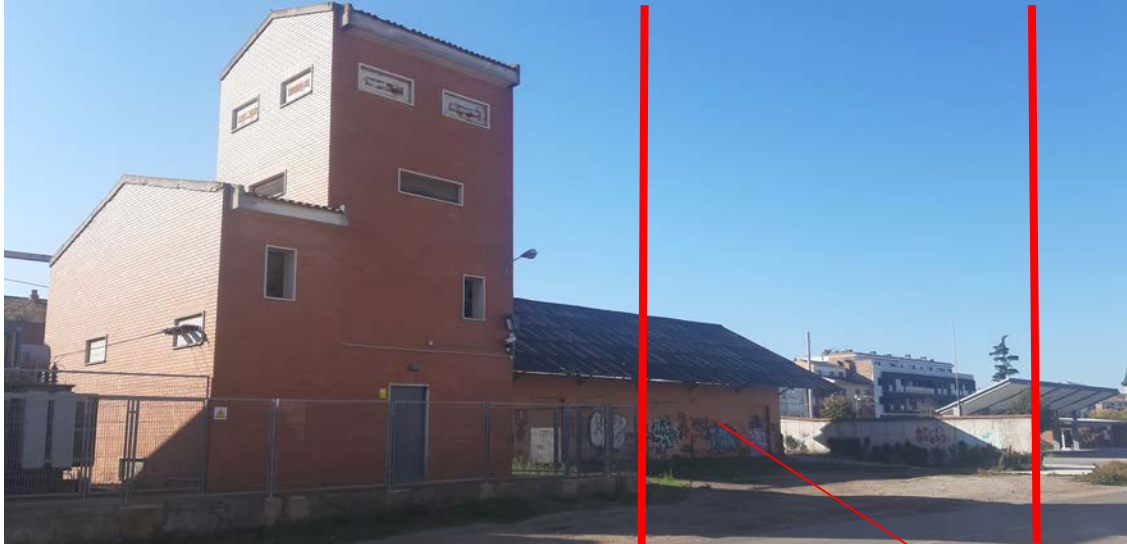
Estació Transformadora del Sistema Ferroviari. (Fins ara Sistema de serveis Tècnics)
