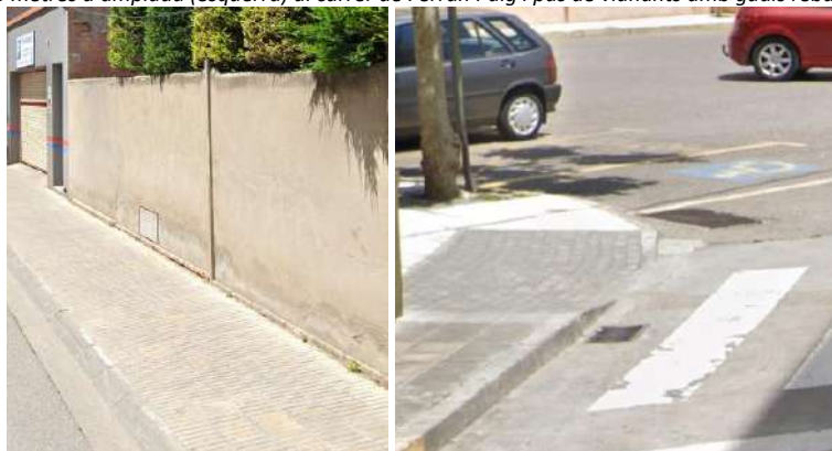
Vorera d'1,5 metres d'amplada (esquerra) al carrer de Ferran Puig i pas de vianants amb guals rebaixats (dreta).
